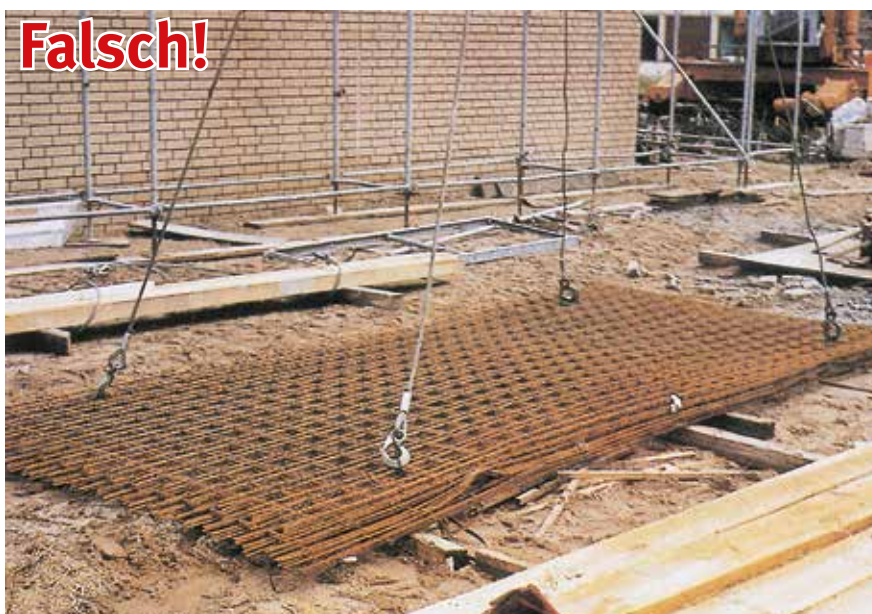
Bild 16-5: Einhängen in die Umschnürung ist lebensgefährlich!
